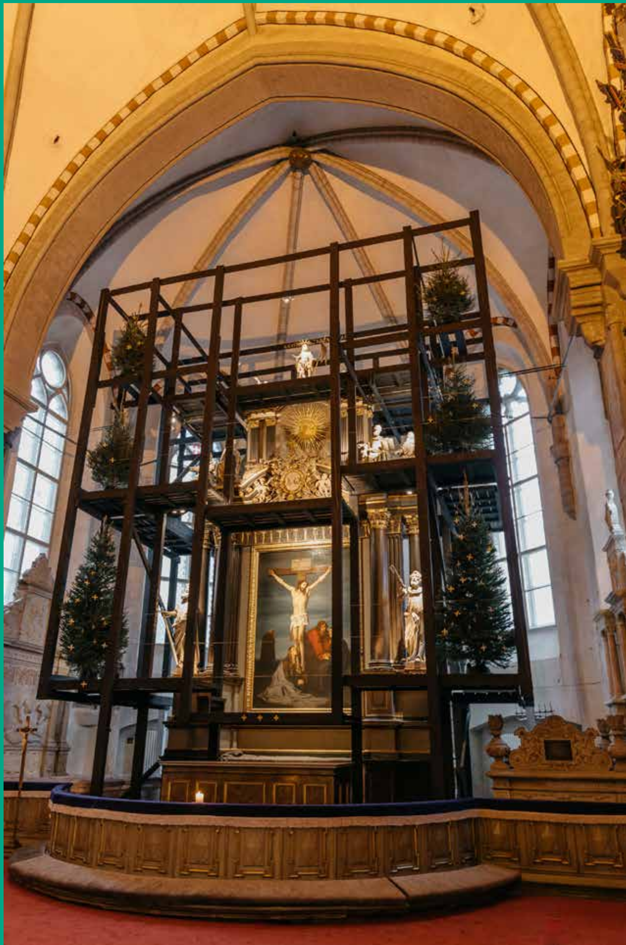
Toomikiriku altari tellingud. Muinsuskaitse ja konserveerimise, sisearhitektuuri ning graafilise disaini osakondade ühisprojekt Christian Ackermanni loomingu uurimiseks. Foto: Tõnu Tunnel
