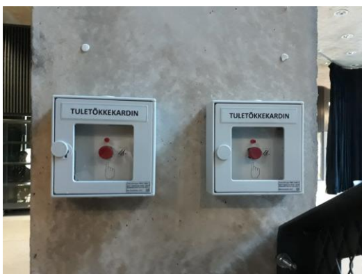
Pilt 15 Tuletõkkekardinate sulgemise/avamise nupud
