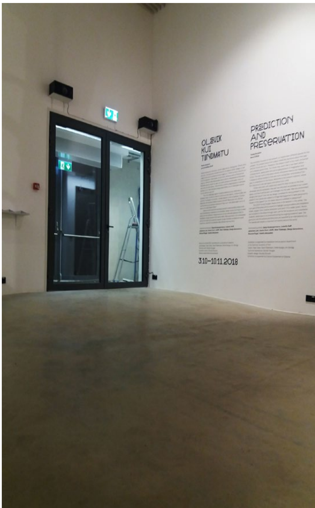
Kõlarid on installeeritud ukse kohale
